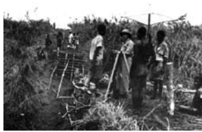
Estruturas para atenuar a inclinação do terreno e galgar um valado
