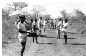
Colocação dos fios sobre os tripés e peso tensor
