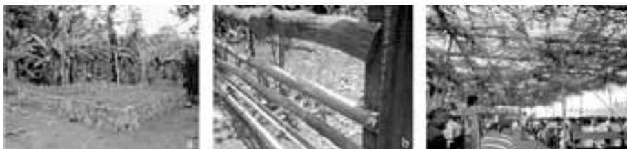
Fig. 019 - Exemplos do uso de materiais locais: (a) pedra vulcânica para embasamento da habitação, (b) aparas de madeira e cana para delimitação do lote, (c) sombreamento com folhas de palmeira. Ilha de São Tomé.
