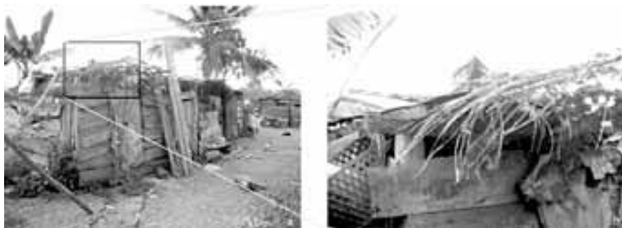
Fig. 021 - Invulgar exemplo de construção popular com cobertura parcialmente vegetal: (a) fotografia da construção, (b) pormenor de uso de folha de palmeira na cobertura. Roça da Boa Entrada, Ilha de São Tomé, 2010.
