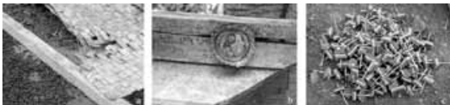
Fig. 020 - Exemplos de reutilização de materiais: (a) malha de tiras de alumínio, (b) anilha de carica, (c) anilha impermeabilizante de chinelo.
