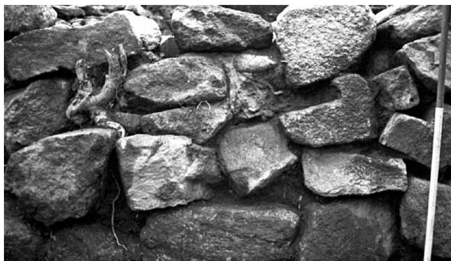
Fig. 2.3 – Pormenor do aparelho da muralha do castro de Penices, notando-se a ausência de aparelhamento e irregularidade das pedras, bem como o travamento deficiente do aparelho.
