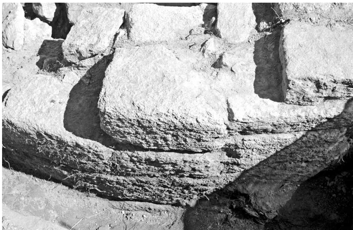
Fig. 4 - Paramento escadrado dunha casa de Castro Lezenho.
