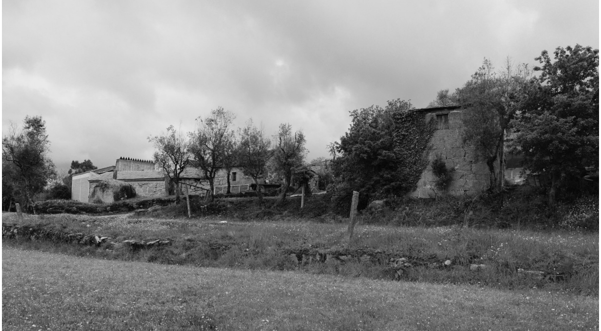
Fig. 3 – Conjunto edificado em que se integra a casa do lagar
