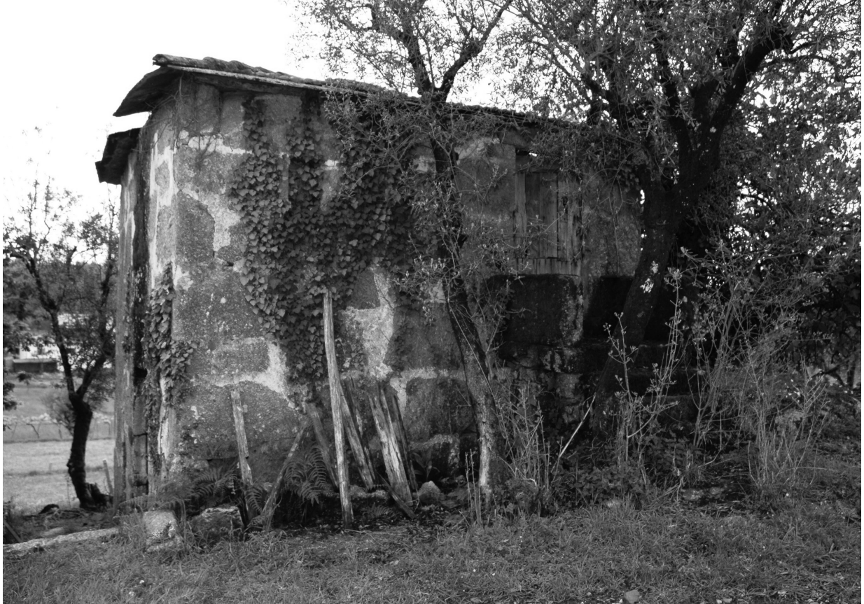
Fig. 5 – Exterior do edifício do lagar
