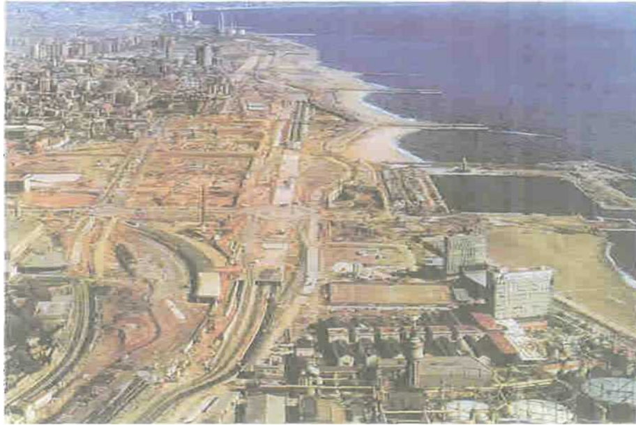
Fig. 3 — Inicio de las obras de la Villa Olímpica
