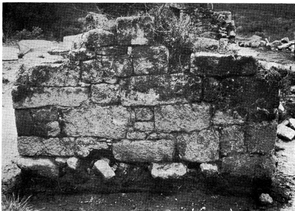
Fig. 2 — Aspecto da parede leste da capela-mor.
