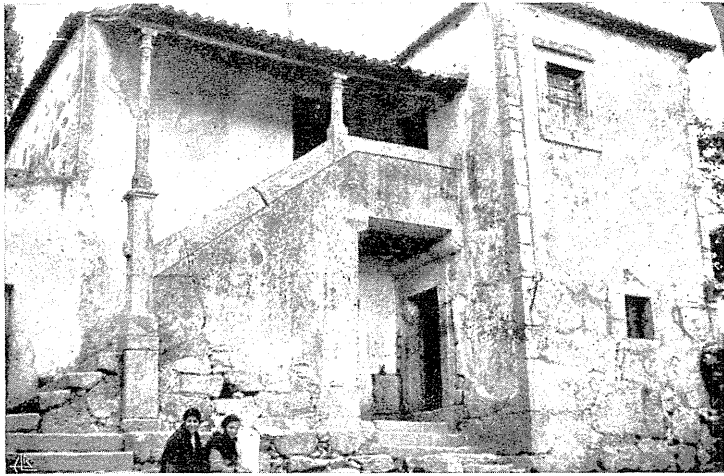
Fig. 2 — Santa Cruz do Bispo — Lugar do Monte dos Outeiros — Casa da Moura — Tipo B característico: a escada de pedra com as duas colunas, o corpo lateral do edifício, e a cozinha térrea (à esquerda). Esta casa parece ser das mais antigas que vimos, e apresenta uma janela no corpo saliente, que não encontramos em qualquer outra. Num pequeno quintal, anexo a esta casa, existe uma boca de poço, formada, entre outras, por uma pedra talhada em redondo, contendo uma inscrição que nos foi impossível decifrar, mas que recomendamos à atenção dos especialistas.
