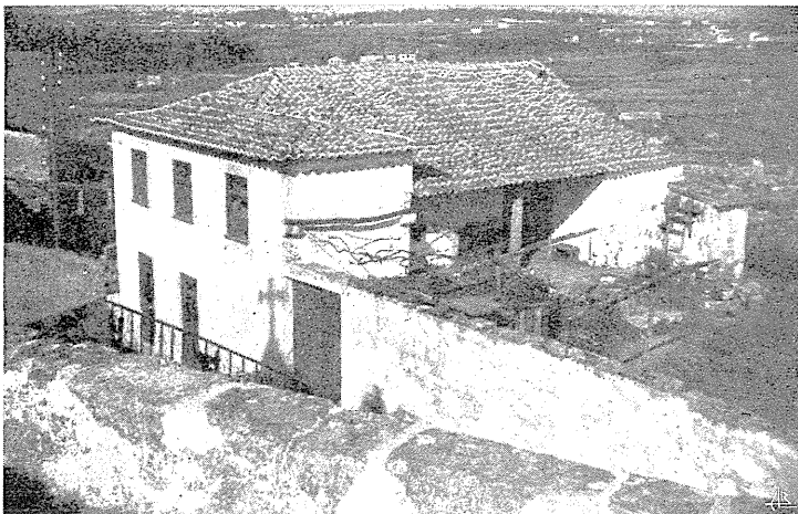
Fig. 1 — Casa em Espozade — Tipo intermediário entre A' e B: pelo aspecto da sua fachada sobre a rua, parece uma casa do tipo B; o andar porém resulta do desnível do terreno, e, para trás, a casa é térrea; vêem-se os dois cubículos, recobertos, um, pela ala lateral e o outro pela água maior do telhado, e o alpendre que corre entre eles, característicos das casas dos tipos A'.
