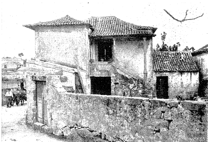
Fig. 3 — Casa em Santa Cruz do Bispo — Tipo B: veja-se a escada com as duas colunas, o corpo lateral saliente, a ala do telhado que lhe corresponde, e a cozinha térrea, sem chaminé.
