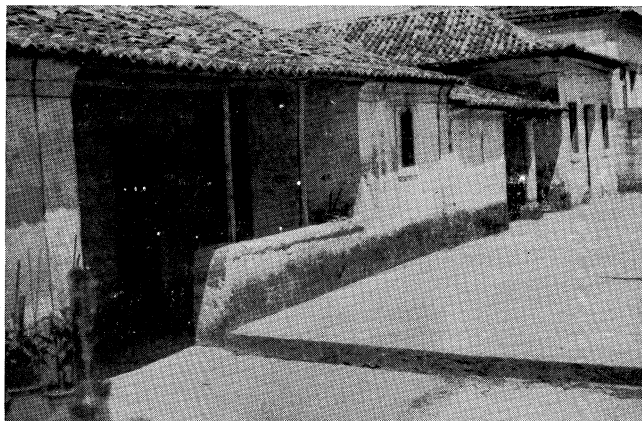
Fotog. 3 — Pardelhas — Casas do tipo 3. Repare-se nos prumos de madeira acima do poal , sustentando o alpendre.
