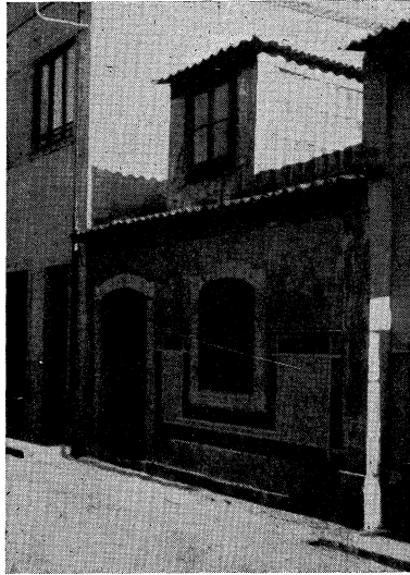
Fig. 9 — «Mirante» recuado a meio da largura do telhado. (R. da Assunção, 41). Esta casa tem na padieira a data duvidosa de 1600.
