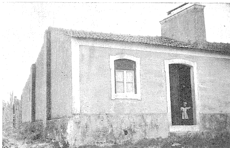
Fig. 10 — S. Paio da Leirosa — Notem-se os contrafortes na empena.
