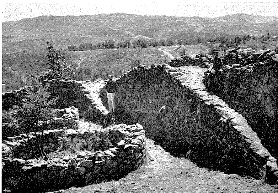
Fig. 4 — Duas casas circulares e duas rampas de acesso à muralha
