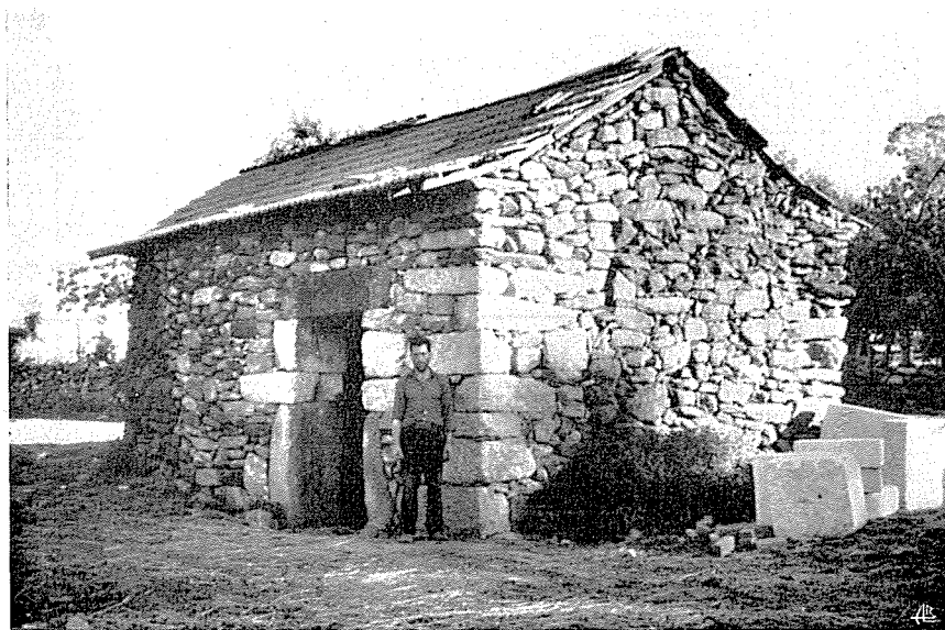
Fig. 14 — O forno actual de Vilarinho da Mó com a nova cobertura de telha francesa.
