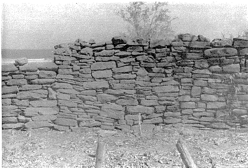
Fig. 5 — Aspecto da muralha do lado sul com cerca de 2 metros de altura
