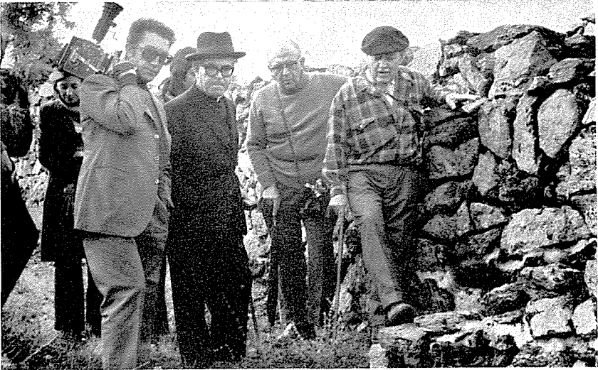
Fig. 3 — No início de outra rampa de acesso à muralha
