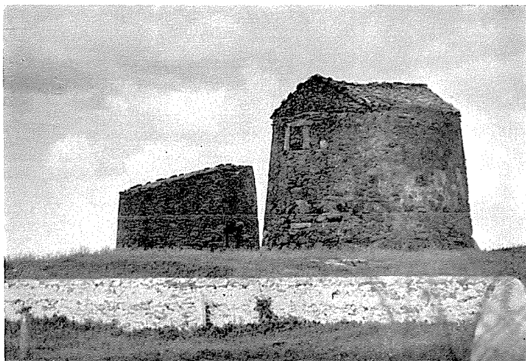
Fig. 1 — Moinhos velhos, à borda da estrada para Ourique, na Aldeia dos Fernandes, freguesia de Gomes Aires, concelho de Almodôvar. Um com o telhado em duas águas e o outro de uma água só.
