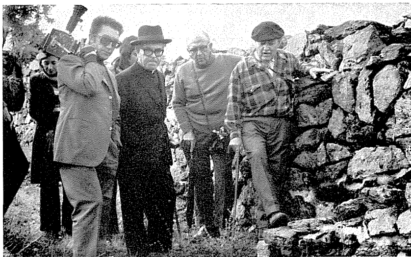
Fig. 3 — No início de outra rampa de acesso à muralha
