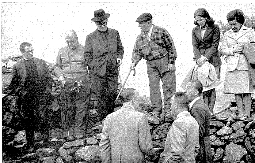
Fig. 4 — Acentuando um pormenor do alargamento da muralha para fazer a rampa
