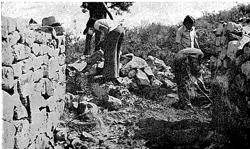
Fig. 15 — Porta de sw. Aspecto dos trabalhos de reposição de pedras nas muralhas e arranjo do pavimento da entrada.
