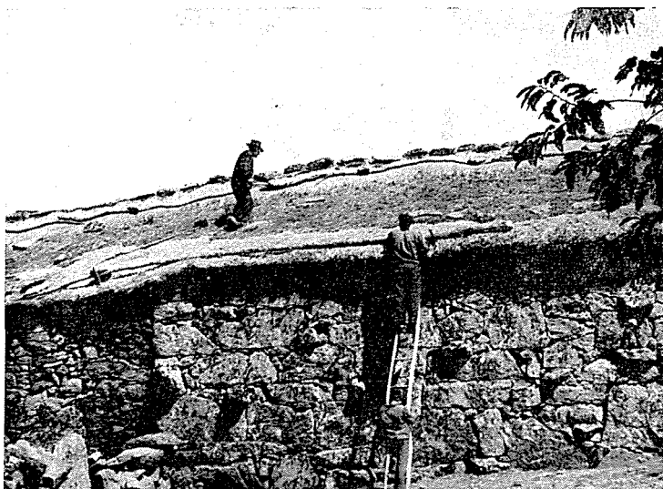
Fig. 63 — Na cobertura de colmo desta casa as partes mais claras são de colmo novo entremeadado e sobreposto ao colmo velho, escurecido pelas invernaadas.
