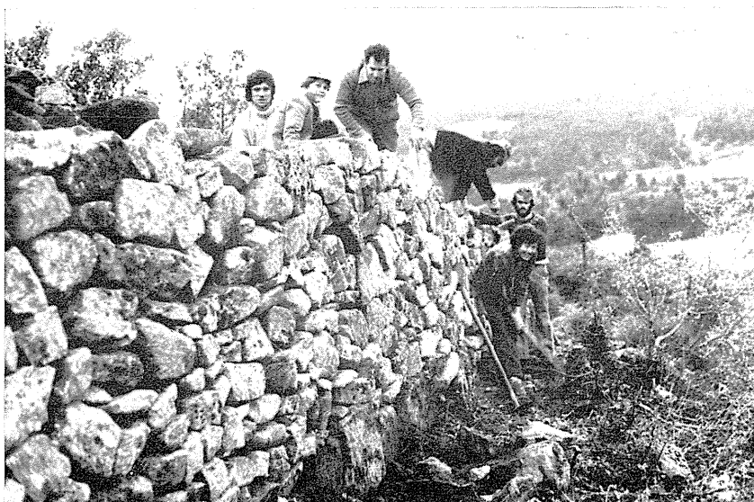
Fig. 10 — Reconstrução da muralha com as pedras dela caídas. Troço a poente da porta norte do castro.
