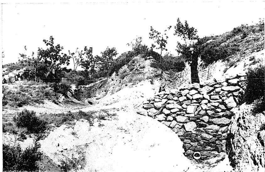
Fig. 10 — Passadiço no fosso 2, na sua confluência com o fosso 3. Feito com pedras do amontoado da fig. anterior.
