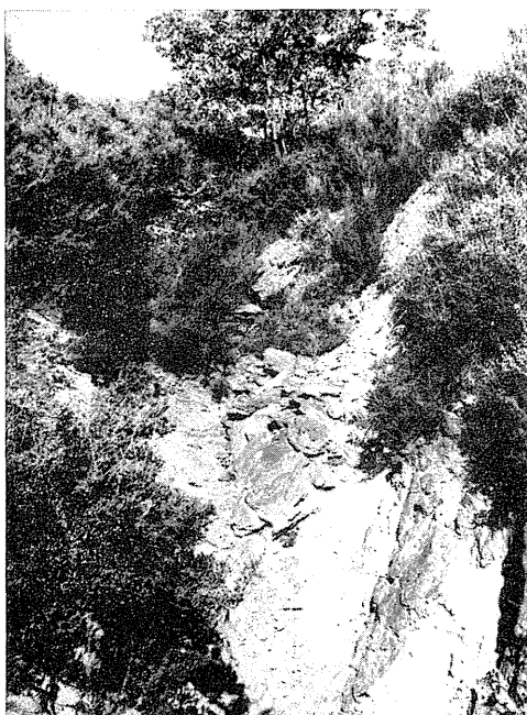
Fig. 7 — O fosso n.º 1 na porção junto da muralha invadido pelo monte, especialmente carqueja e giesta.
