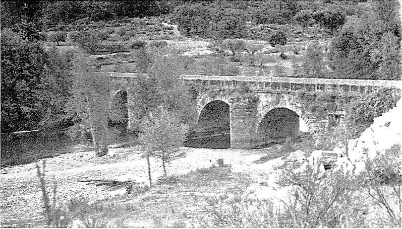
Fig. 1 — Vista geral da Ponte de Pedra.
