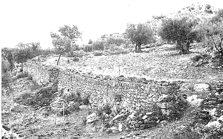
Fig. 7 — Troço do 2.º paredão para norte da portada.
