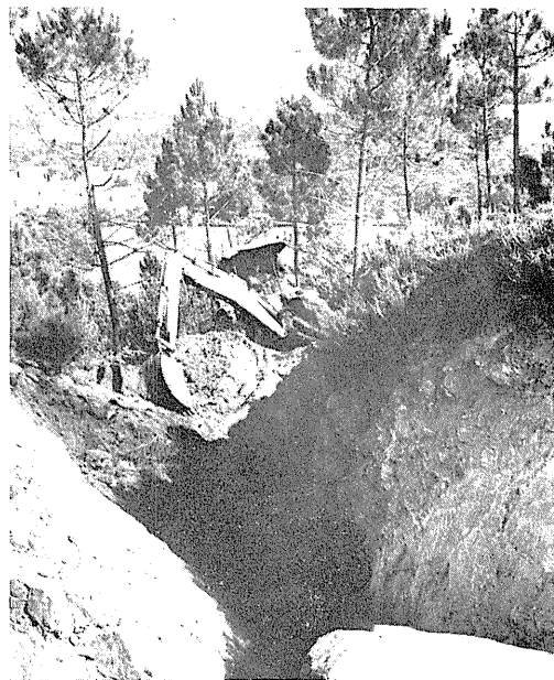
Fig. 6 — A máquina escavadora no início do ataque à testeira da fig. anterior.
