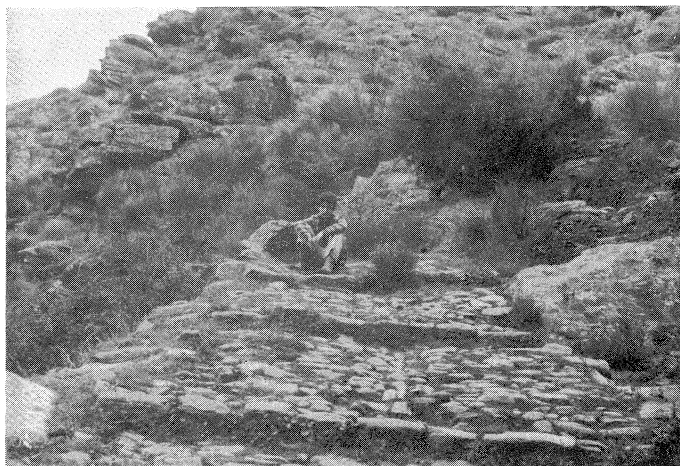
Fig. 9 — Os patamares são limitados por fiadas de pedras postas ao través.
