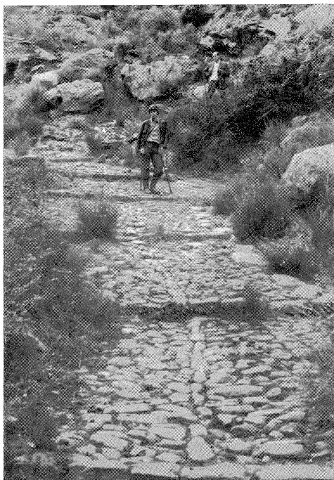
Fig. 8 — Calçada de Alpajares. Sucessão de 6 patamares antecedendo uma recta.
