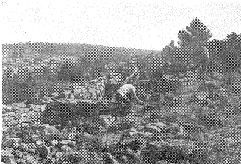
Fig. 5 — Aspecto dos trabalhos na parede linear do lado Sul, comum a toda a fiada de casas.
