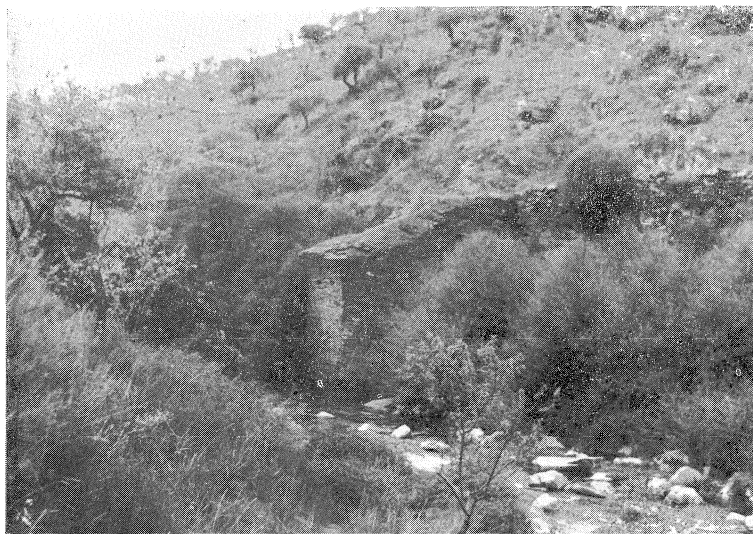
Fig. 4 — Encontro na margem direita da velha ponte do Diabo.
