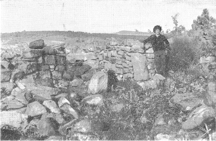
Fig. 15 — Restos da casa arruinada ao lado da porta do lado norte. A porta encoberta pelo homem e pela giesta.
