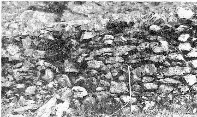
Fig. 14 — Porção do paredão que serve de apoio à calçada. A bengala mede 82 cm.
