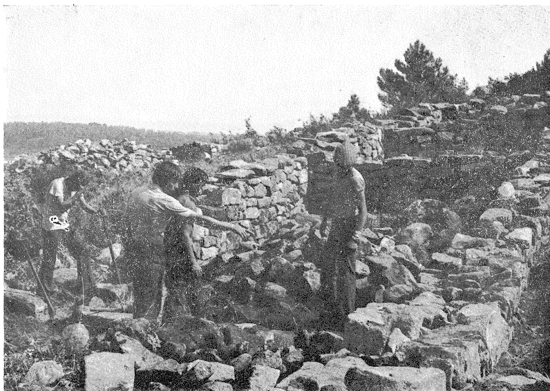
Fig. 6 — Aspecto dos trabalhos na casa n.º 11.
