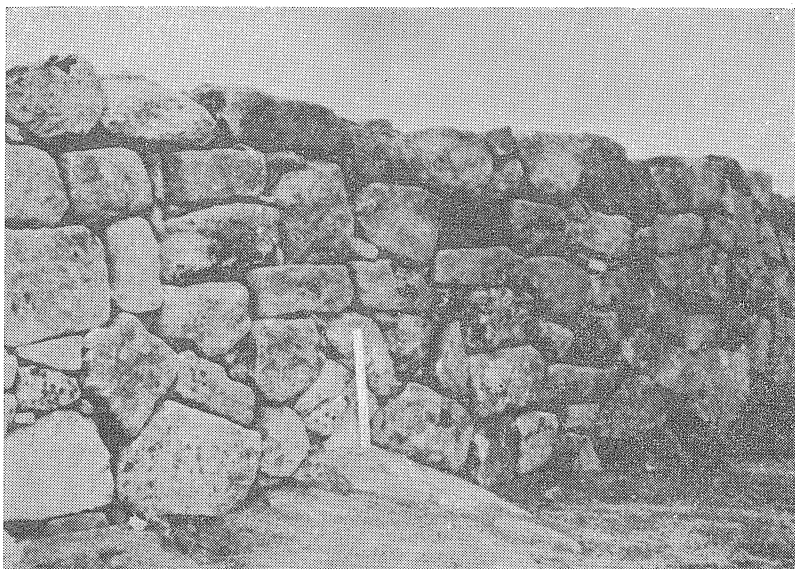
Fig. 7 — A muralha central, entre as portas E e N no final dos trabalhos (régua = 40 cm).
