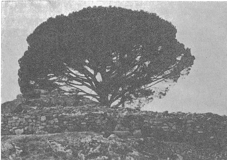
Fig. 8 — Imagem parcial da muralha central, entre as portas E e N no final dos trabalhos.
