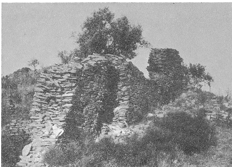
Fig. 5— O que resta duma parede com 1,10 m de grossura. Tem 20 m de comprimento com altura de 2,70 m convexidade da 1. a porção e 3 m de altura na parte terminal atorreada.
