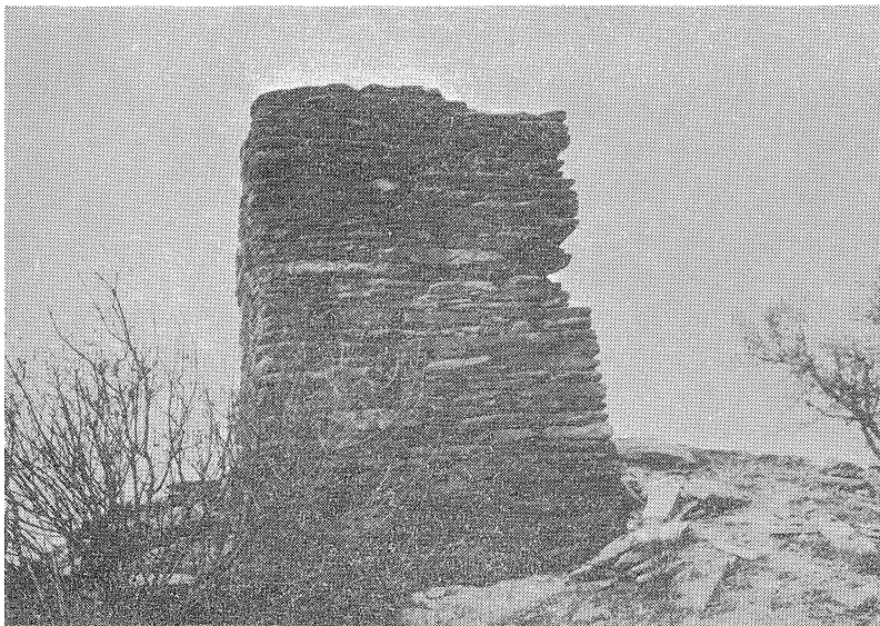
Fig. 7 — Lado sul da torre da fig. anterior.
