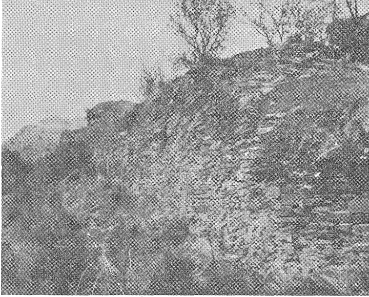
Fig. 4 — Porção da muralha do lado poente alinhamento do sul para norte.
